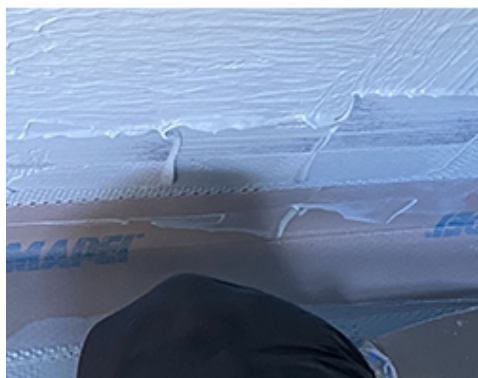
Application de Mapeband PE 120 dans la jonction sol/mur avec Mapelastic Aquadefense Evo
