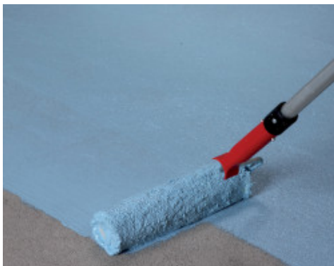
Application au rouleau de la première passe de Mapelastic Aquadefense Evo
