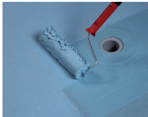
Application au rouleau de la seconde passe de Mapelastic Aquadefense Evo
