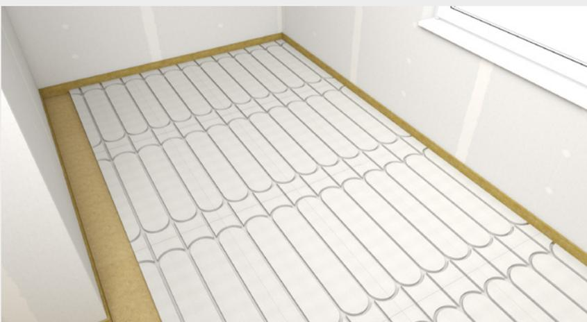
Après la pose des canalisations de chauffage, elles doivent être mises sous pression pour vérifier l'absence de fuites sur le système de chauffage au sol. Les plaques fibres-gypse fermacell® complémentaires (épaisseur suivant le domaine d'application) peuvent alors être posées. Les joints de cette couche doivent être décalés d'au moins 167 mm par rapport à ceux des
