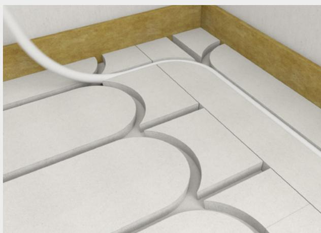
Les canalisations de chauffage (16 mm) sont mises en place. Les rainures spécialement fraisées ne nécessitent aucune fixation supplémentaire des tuyaux. Il est également possible de poser le réseau au sol sans utiliser la plaque de sol Therm25™ à rainures en rond.
