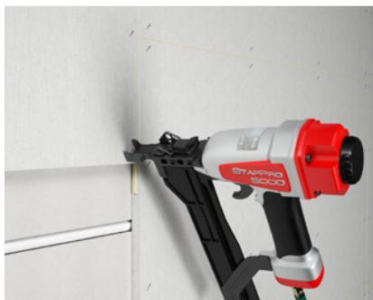
Fixation de la couche supplémentaire de plaques fibres-gypse fermacell® ou Powerpanel H<sub>2</sub>O, avec joint de raccord
