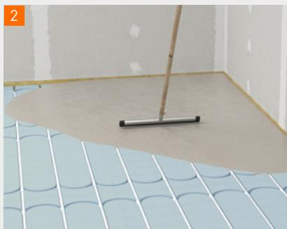
2 Coulage de mortier adhésif fermacell™ sur les plaques de sol Therm25™.
